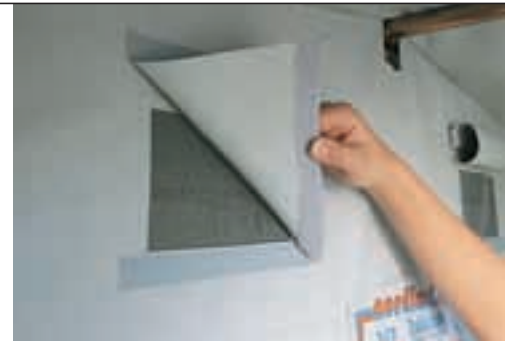
Verschiebbare Giebellüftung
